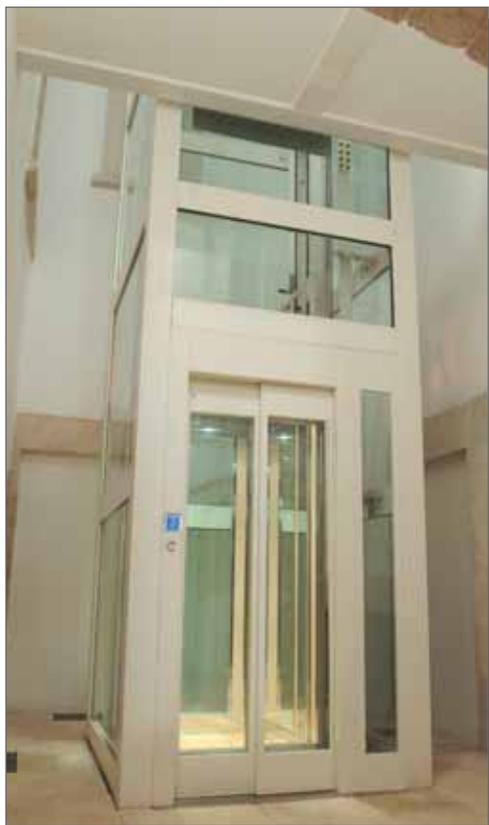
L'esclusiva struttura che Ascensori C.M.A. propone alla sua clientela è progettata e realizzata per assemblare incastellature metalliche autoportanti e non, anche per zona sismica, particolarmente indicate per realizzare vano corsa in edifici esistenti anche di valore storico o artistico.
